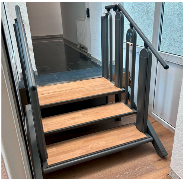
Neue Rampe am Dienstgebäude Chemnitz, diese wurde 2023 in Betrieb genommen
